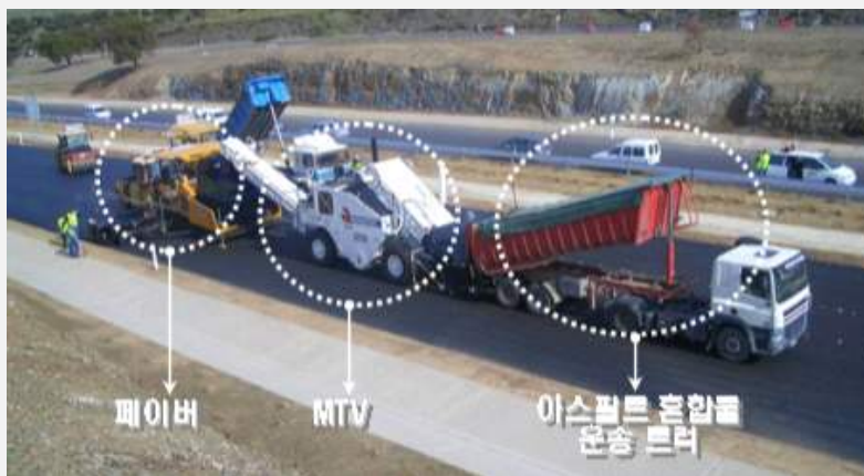
< MTV를 활용한 시공 장면 >
