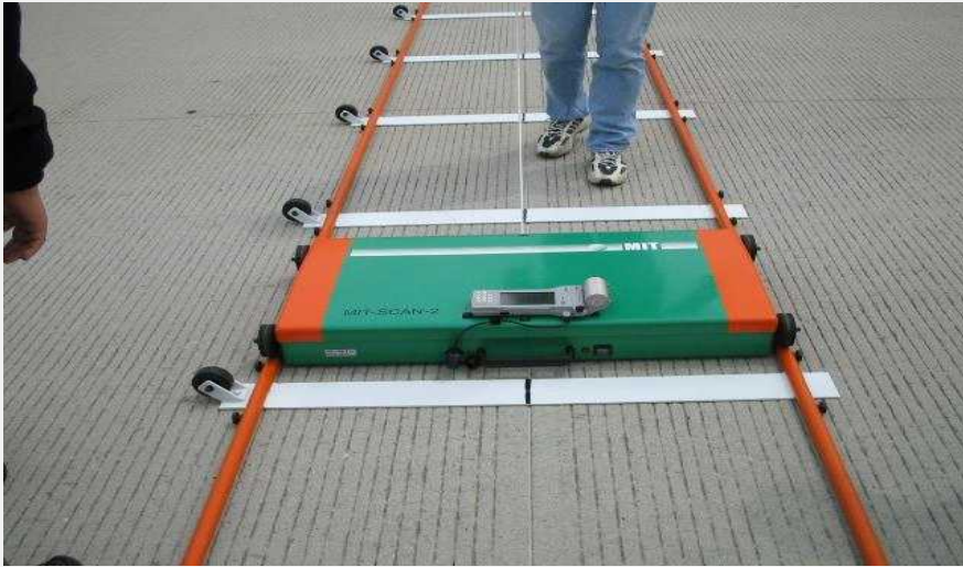
<그림 5.8> MIT-SCAN을 활용한 다웰바 시공 상태 현장 조사
