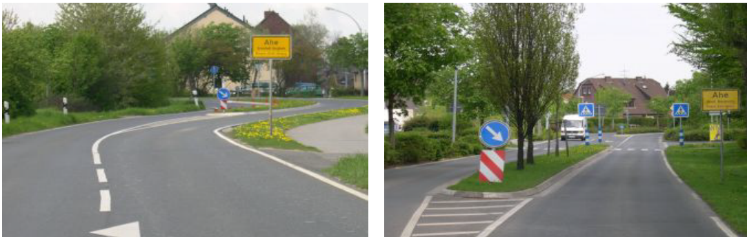
〈그림 5-10〉 지그재그 형태의 도로와 차로 폭 좁힘을 통한 자동차 주행속도 관리
