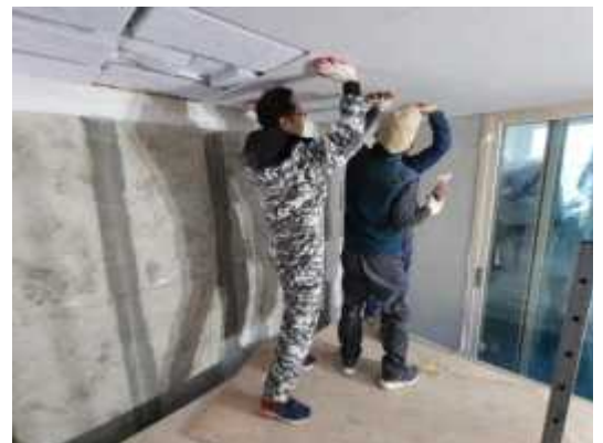
(6) 신규 천장판 설치
