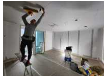
(6) 도배 및 설비류 재설치, 천장돌림 재시공
