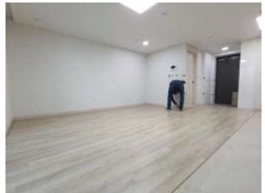
(6) 용착제 도포 후 굽도리 설치
