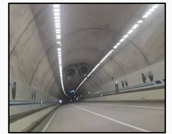
[터널 환기설비 설치]
