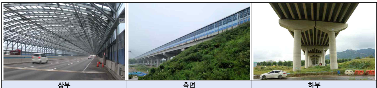
[사진 2] ○○교 설치 전경
