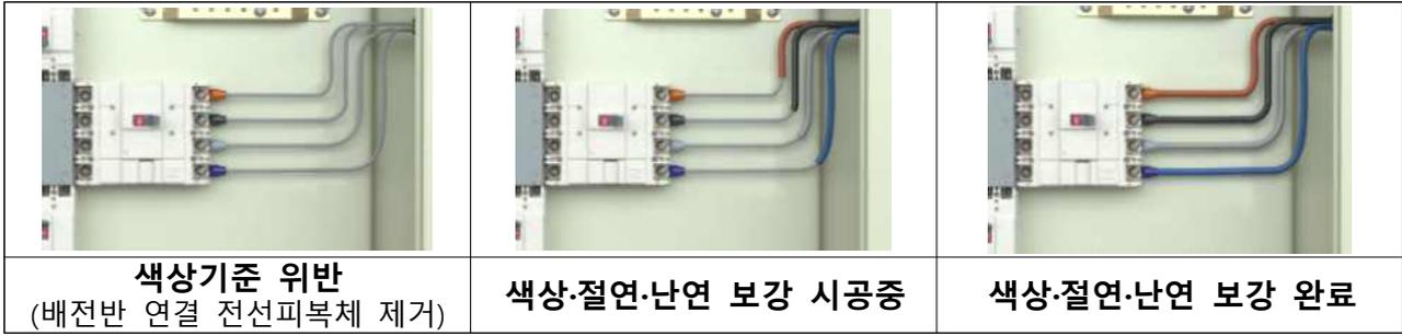
○ 그런데 케이블 전선 색상 구분 표시 등에 대한 점검결과, 전력공급을 위한 케이블의 색상이 [그림5]와 같이 구분 표시되지 않아 향후 정비과정에서 잘못 연결하는 경우 조명등보다 과잉전압이 발생하여 케이블 발열 및 조명등 파손 등을 초래할 수 있고, 케이블 색상 미확인으로 전선 3선 중 1선에 많은 조명등 연결로 과부하가 발생할 우려<sup>27)</sup>가 있음을 확인하였다.
