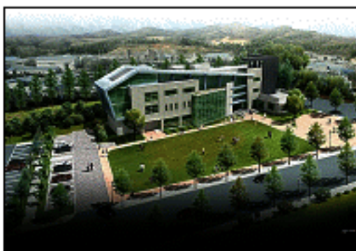
<속초 젓갈콤플렉스 전경>
