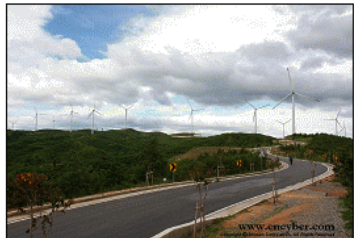
<영덕 풍력발전단지 전경>
