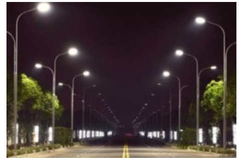
<LED 가로등 설치>
