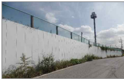
가설방음판넬 설치(예시)
