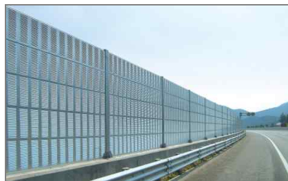
방음벽 설치(예시)
