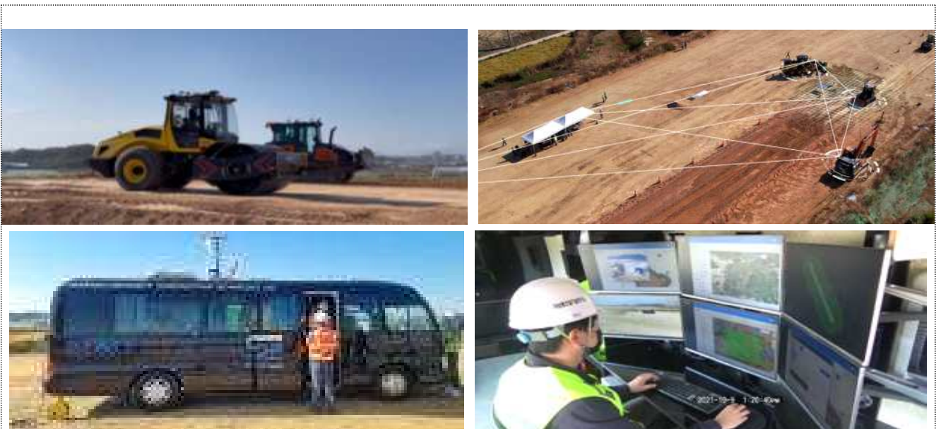
이동식 센터의 관제에 따라 무인 자동화 토공 진행 모습*
