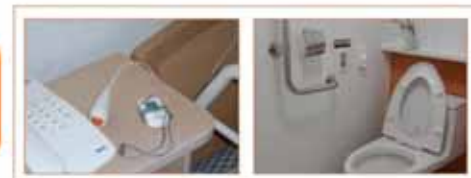
화재용 호출기 및 욕실 내 비상용 설치로 비상 호출 시스템 구축
