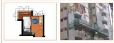
발코니 및 부속 공간을 PC(Precast Concrete) UNIT로 적용해 증축
