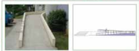
핸드레일을 미설치로 인한 추락 사고 방지를 위해 경사로를 높낮이를 고려한 핸드레일 설치
