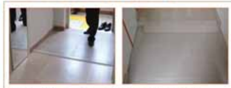
문턱은 바닥의 미끄럼 방지 물질로 개선하여 입주자의 안전한 통행에 기능하도록 배려
