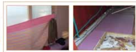
고효율의 단열재로 교체하여 실내온도 유지능 개선 및 에너지 절약 향상
