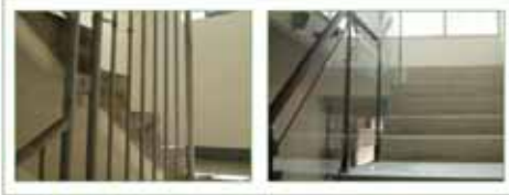
안전성을 고려한 핸드레일과 난간등의 적절한 조성 및 설치로 안전성 확보
