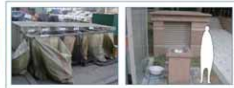
분리수거함과 재활용을 보관소 옆에 수전시설을 설치하여 위생과 안전을 배려
