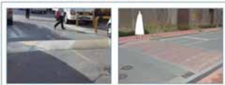
안전사고 예방을 위하여 차량의 서행유도 시설을 설치 및 안전한 도로망 조성
