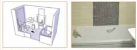
위생도기의 모서리 부분을 평면하고 높낮이를 조절하여 거동이 불편한 입주자의 편의를 고려
