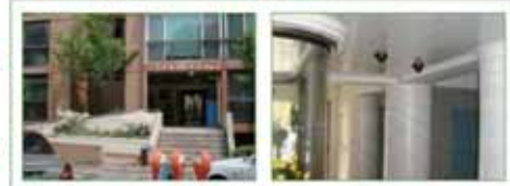
방범 효과가 뛰어난 주동 출입구에 CCTV를 설치하여 범죄 예방 및 입체적 안전 효과 강화
