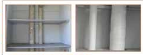
배관설비교체로미관상 문제 및 악취 등의 생활 불편을 해소
