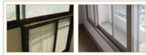
이들 유리를 갖춘 창호 시스템으로 외부 소음이 차단 및 소음 전달 효과 향상
