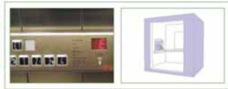
휠체어 사용자를 고려해 조작판 위치 조정 및 감지센서 배치를 설치
