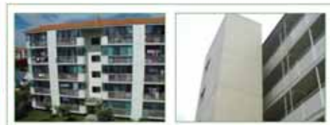
저층 아파트에 승강기 설치로 고령자 및 장애인 사용자의 편의 고려
