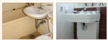
높낮이가 조절되는 세면대를 설치하여 사용자의 편의 도모
