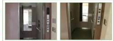
사용자의 편의성 향상을 위한 핸드레일 설치 및 휠체어 사용자를 고려한 전면거울 부착
