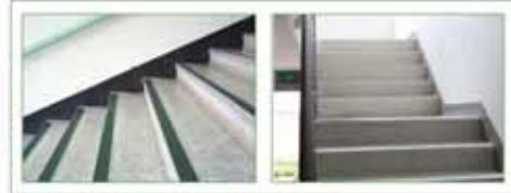
보행자의 안전을 고려한 계단 정비 및 난슬립 설치로 안전성 확보
