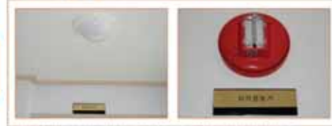
화재감지기, 소화설비등을 신설하거나 노후된 경우 교체하여 화재에 대한 안전성 확보
