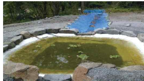
가배수로 및 침사지 설치(예시)
